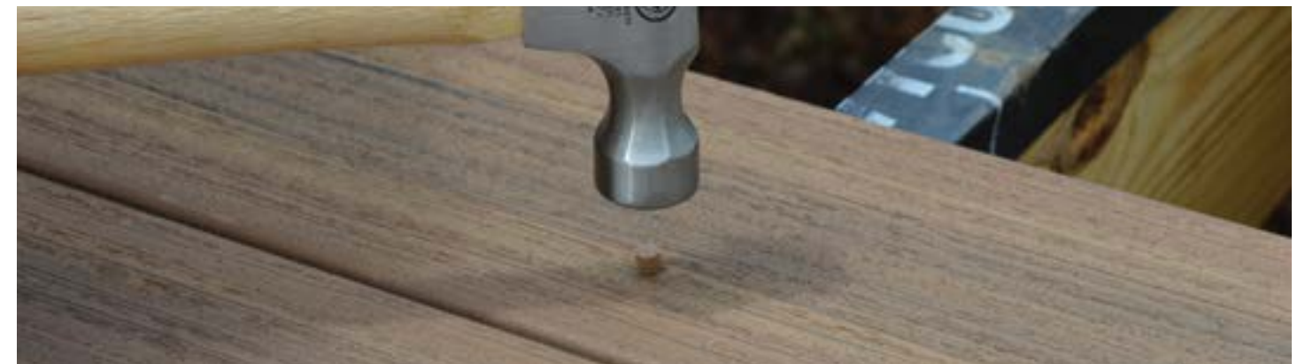
A continuación, se coloca el tapón del mismo color con una maza.
